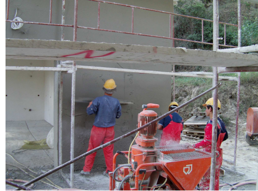
Εφαρμογή Εξωτερικής Θερμομόνωσης σε μεζονέτες στη Κεφαλονιά.
